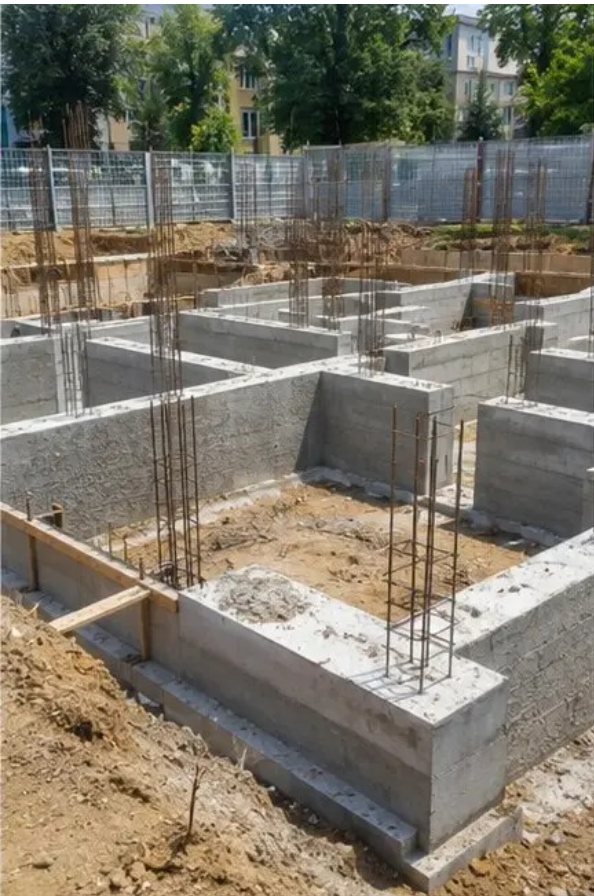
Слика бр.3 Изградња темеља у току
