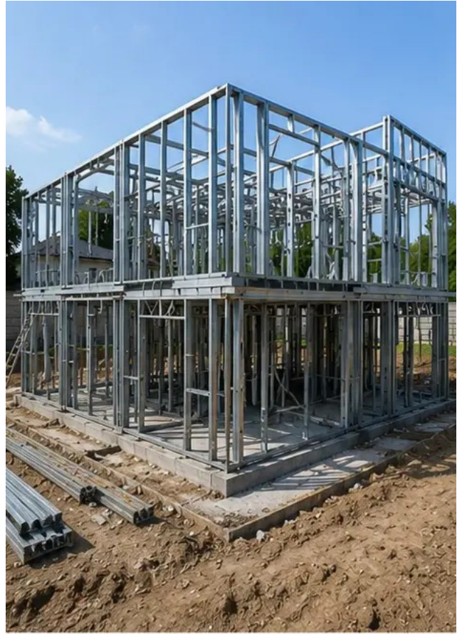
Слика бр.6 Монтажа носеће конструкције у току
