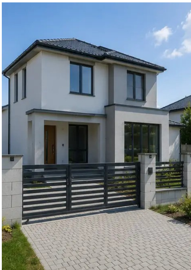
Слика бр.15 Завршена спољашњост зграде након изградње
