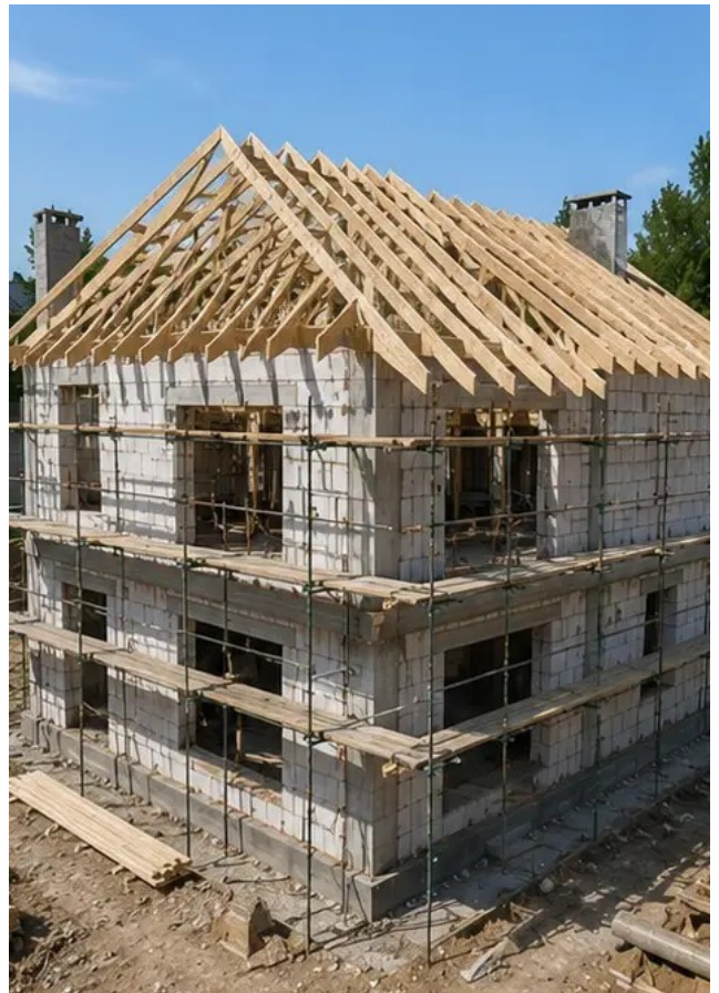
Слика бр.8 Радови на постављању крова завршени
