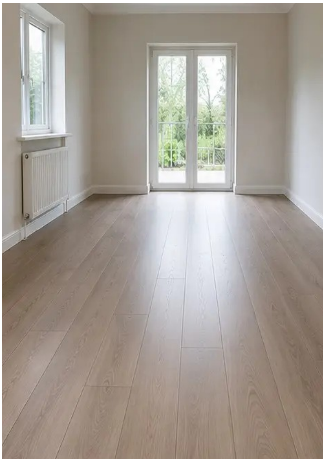
Слика бр.6 Стање пода након замене
