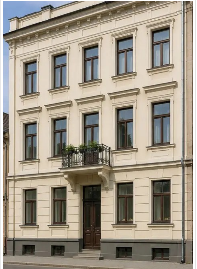
Слика бр.14 Фасада зграде након рестаураторских радова
