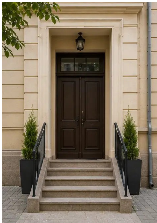
Слика бр.16 Property entrance after improvement
