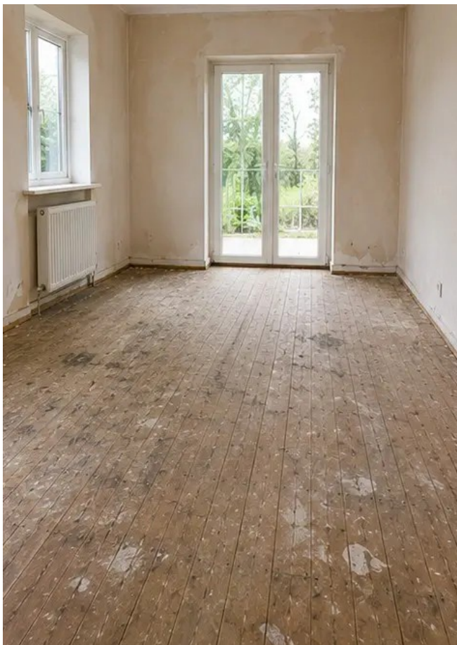
Слика бр.5 Стање пода пре замене
