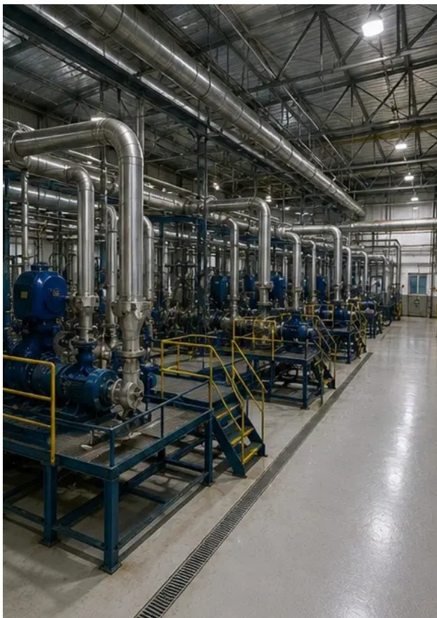
Слика бр.16. Општи преглед објекта након завршетка радова одржавања
