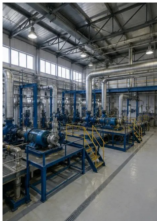
Слика бр.1. Општи преглед индустријског објекта
