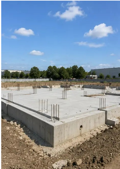
Слика бр.5. Изградња темеља завршена
