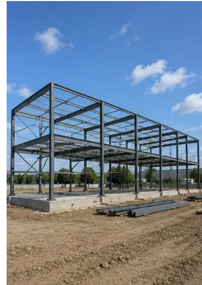
Слика бр.7. Изградња носеће конструкције у току
