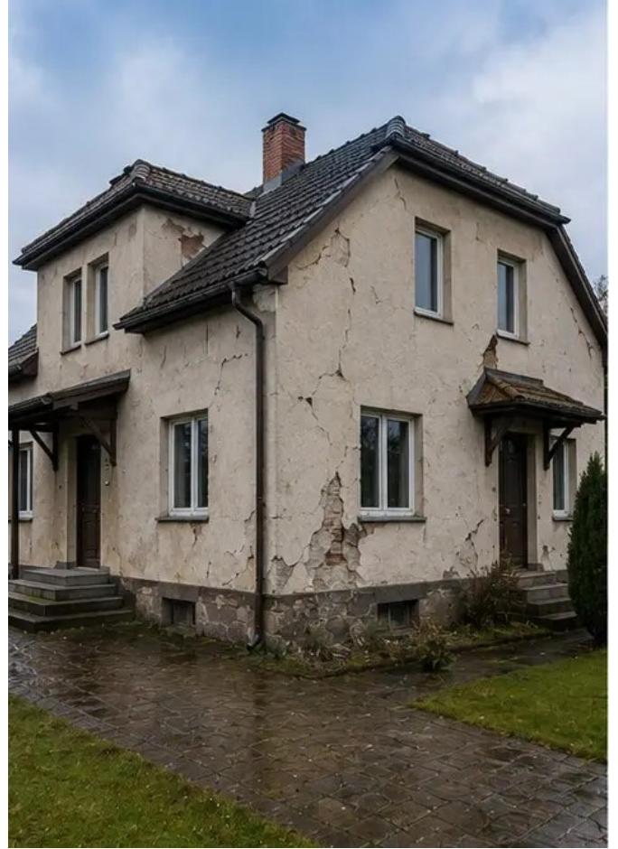
Foto Nr.1 Pamje e përgjithshme e pronës së inspektuar
