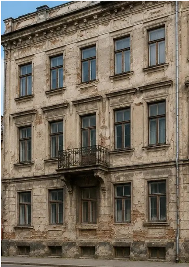
Foto Nr.13 Fasada e ndërtesës para punimeve restauruese
