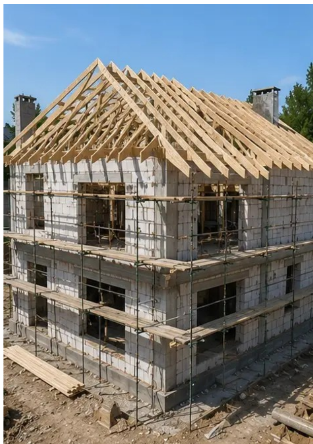
Foto Nr.8 Punimet e instalimit të çatisë përfunduan
