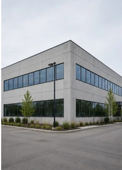
Photo #1. Pamje e përgjithshme e pronës së inspektuar
