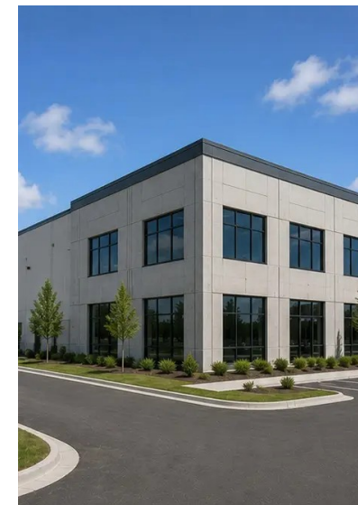
Foto Nr.16. Projekti i përfunduar gati për funksionim
