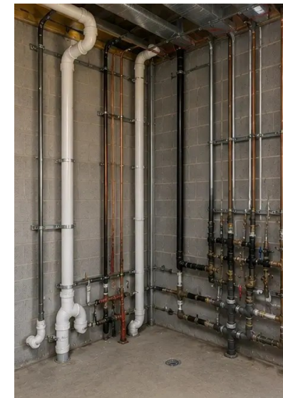
Foto Nr.12. Instalimi i sistemeve hidraulike përfundoi
