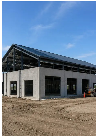
Foto Nr.10. Ndërtimi i çatisë përfundoi
