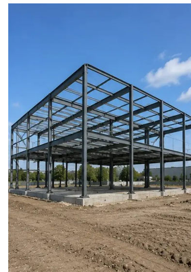
Foto Nr.8. Struktura mbajtëse përfundoi sipas planit të projektit
