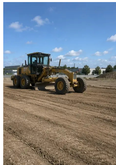
Foto Nr.3. Pastrimi dhe nivelimi i terrenit përfundoi
