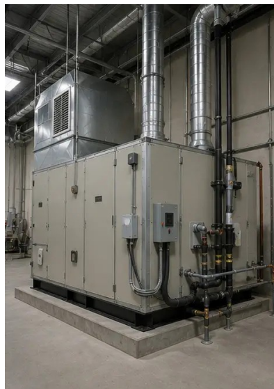
Foto Nr.14. Instalimi i pajisjeve përfundoi
