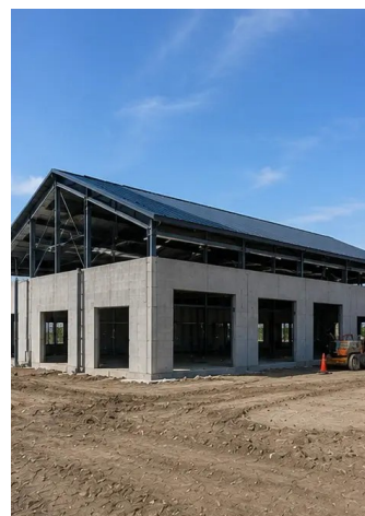
Foto Nr.10. Ndërtimi i çatisë përfundoi
