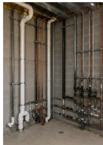
Foto Nr.12. Instalimi i sistemeve hidraulike përfundoi
