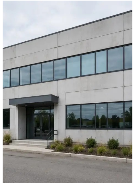
Photo #2. Stanje sprednje fasade med pregledom
