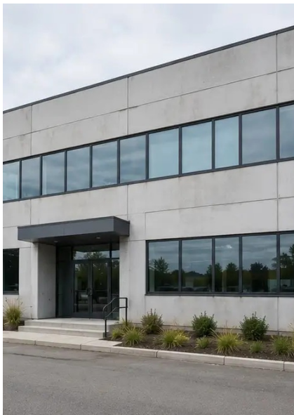
Photo #2. Stanje sprednje fasade med pregledom
