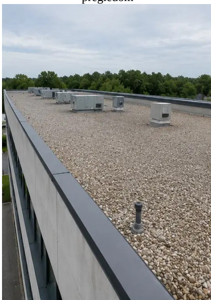
Photo #5. Pregled stanja strehe zaključen
