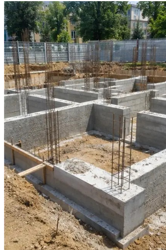
Foto št.3 Gradnja temeljev v teku
