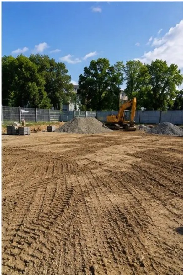
Foto št.1 Pripravljalna dela na gradbišču zaključena pred začetkom gradnje
