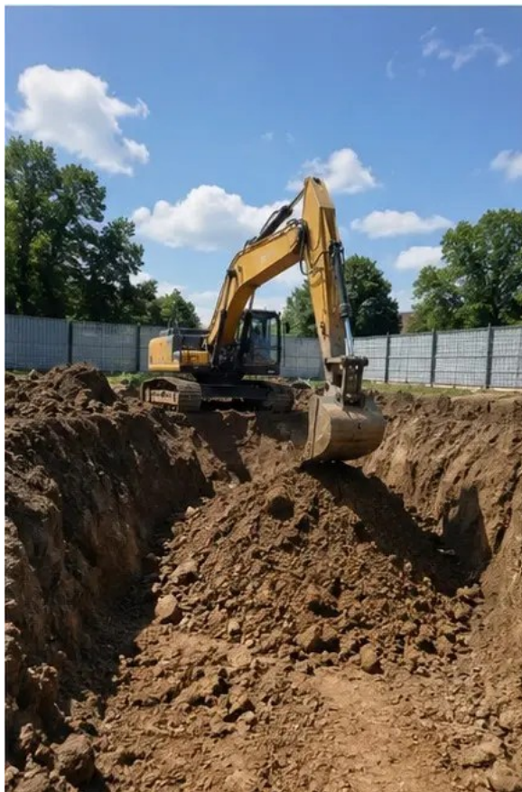
Foto št.2 Izkopi izvedeni skladno s projektnimi zahtevami
