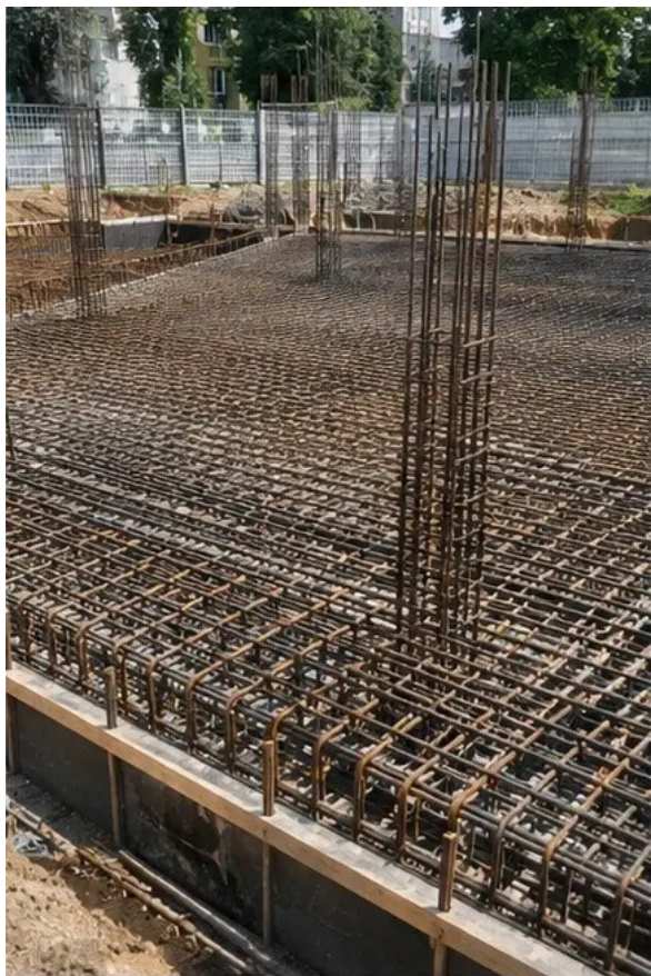
Foto št.4 Montaža armature končana pred betoniranjem
