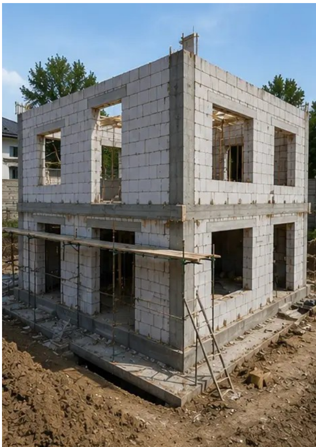
Foto št.7 Gradnja zunanjih sten zaključena za del stavbe
