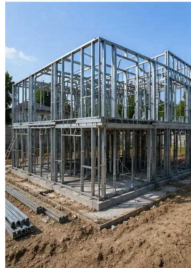
Foto št.6 Montaža nosilne konstrukcije v teku
