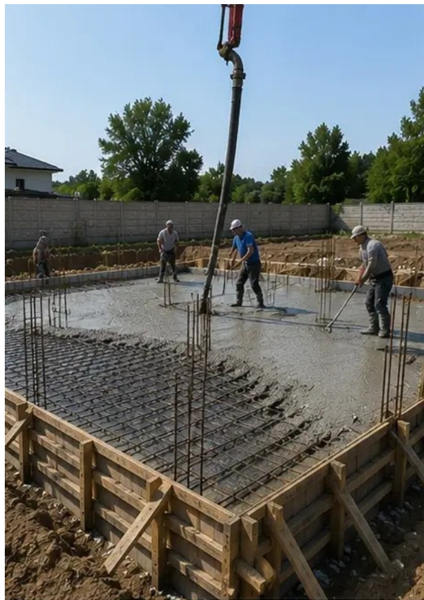
Foto št.5 Betoniranje izvedeno na temeljnih elementih
