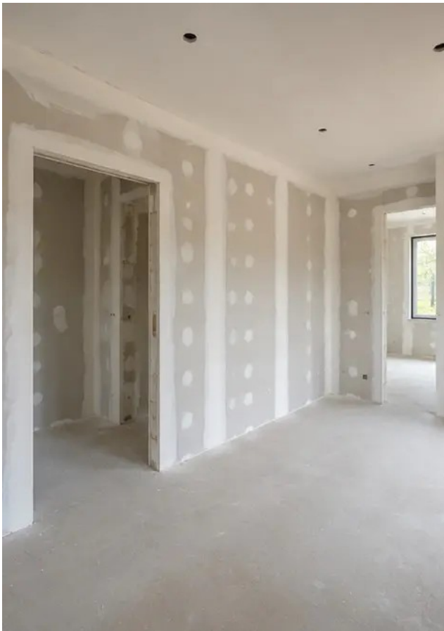
Foto št.11 Zaključna dela na notranjih stenah v teku
