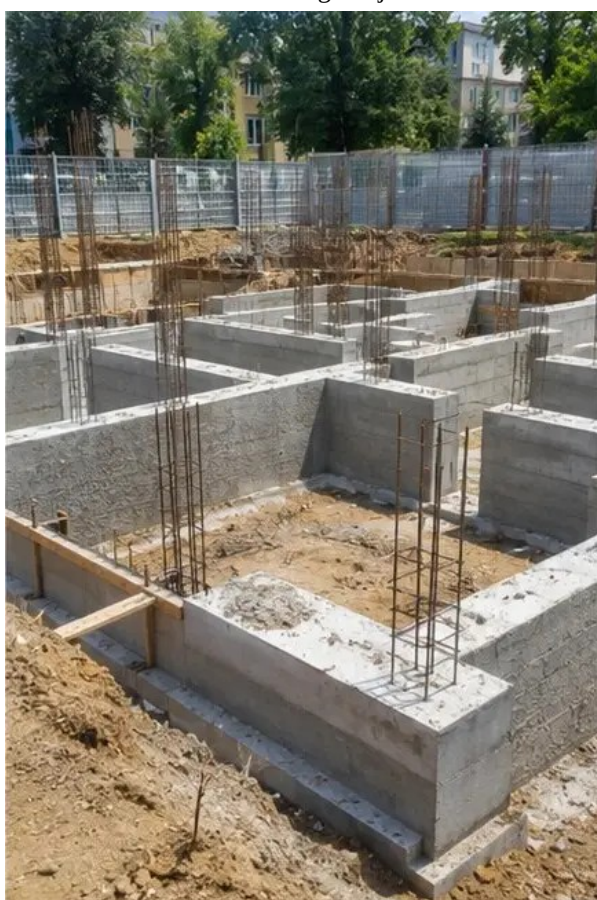
Foto št.3 Gradnja temeljev v teku
