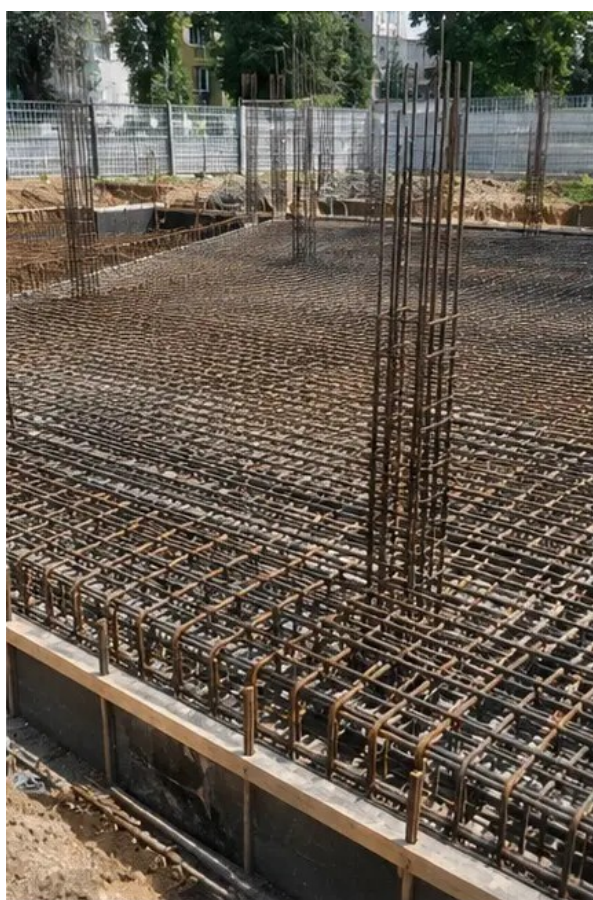
Foto št.4 Montaža armature končana pred betoniranjem
