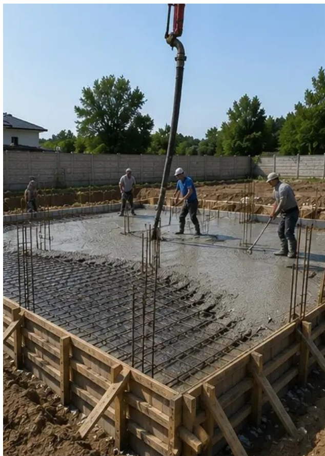
Foto št.5 Betoniranje izvedeno na temeljnih elementih
