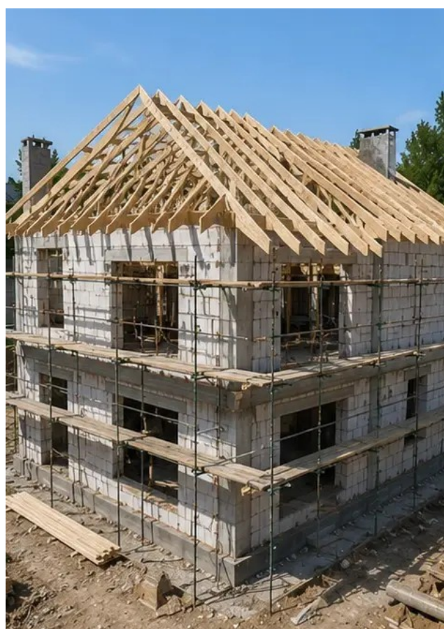
Foto št.8 Montaža strehe zaključena
