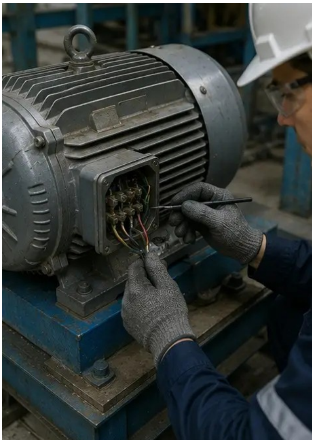
Foto št.4. Pregled elektromotorja zaključen
