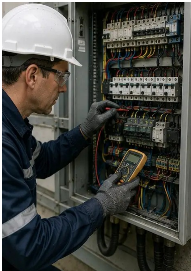
Foto št.5. Pregled električne omare opravljen
