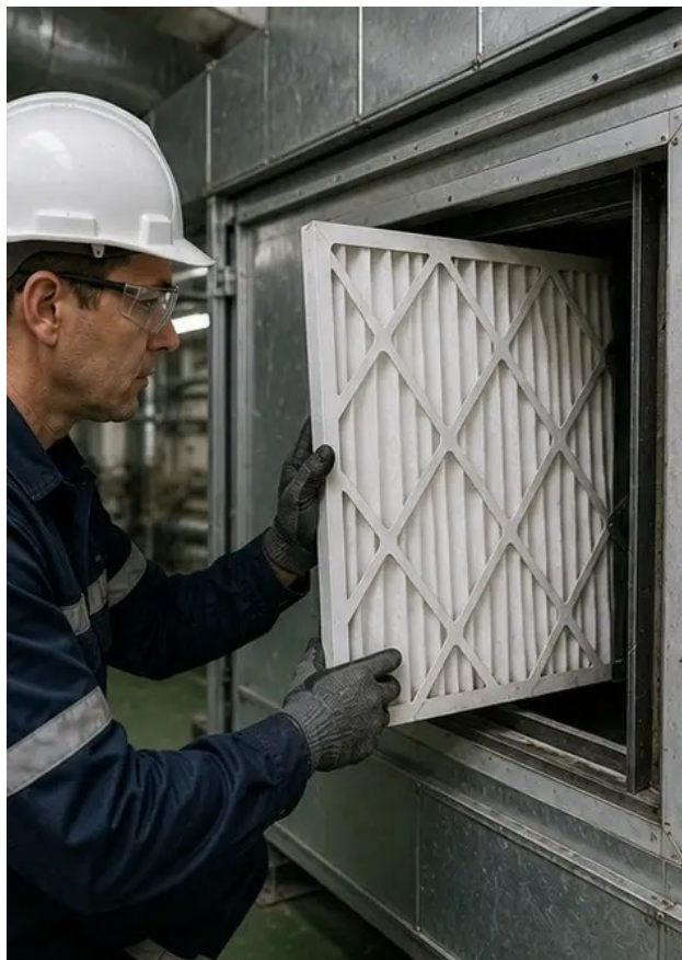
Foto št.7. Zamenjava zračnega filtra končana
