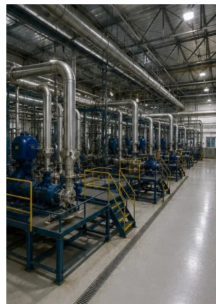
Foto št.16. Splošen pregled obrata po zaključku vzdrževalnih del
