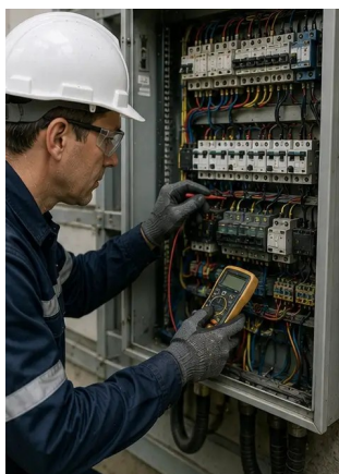
Foto št.5. Pregled električne omare opravljen
