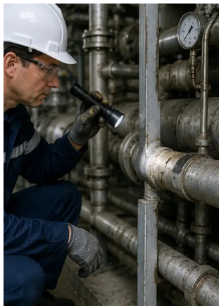
Foto št.9. Pregled cevi opravljen po načrtu vzdrževanja
