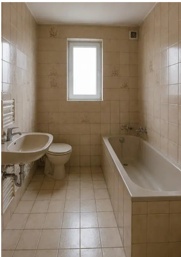
Foto št.9 Stanje kopalnice pred prenovo
