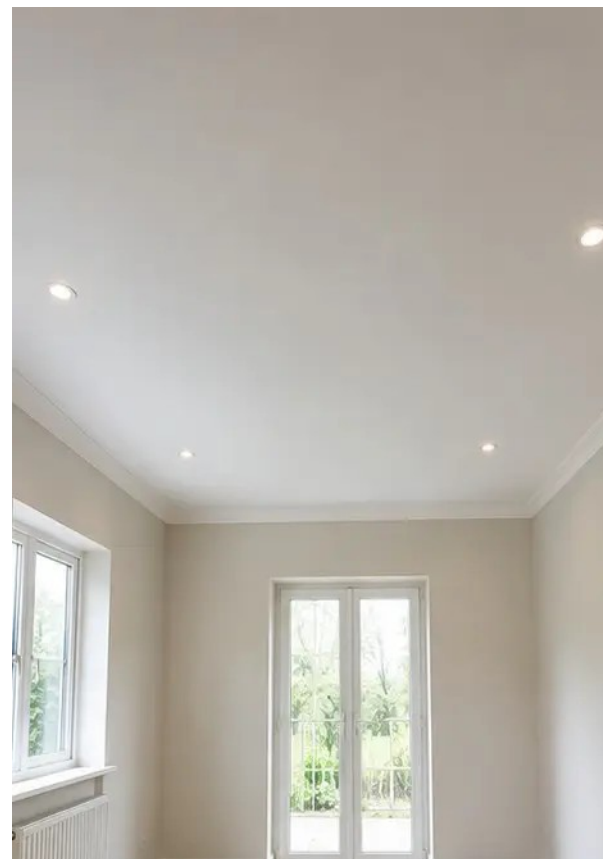
Foto št.8 Stanje stroga po prenovi
