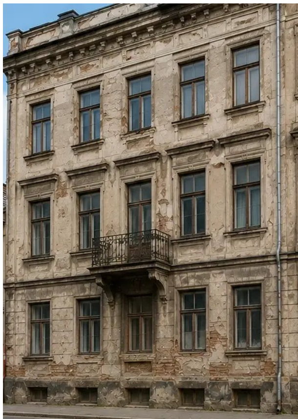
Foto št.13 Fasada stavbe pred obnovitvenimi deli
