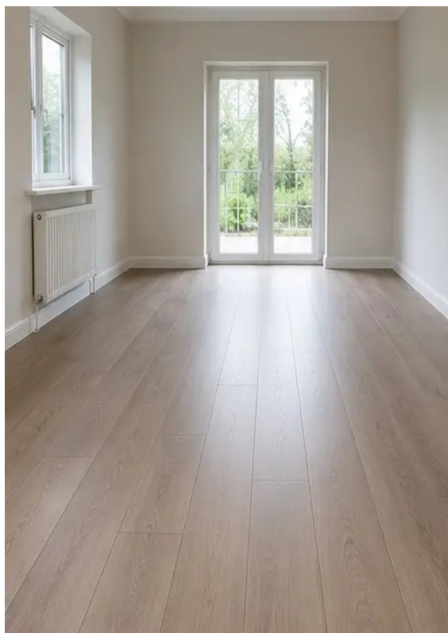
Foto št.6 Stanje talne obloge po zamenjavi
