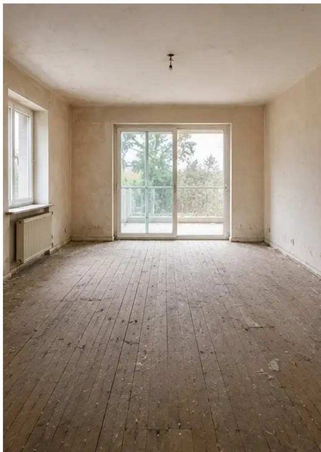
Foto št.1 Stanje dnevne sobe pred prenovo
