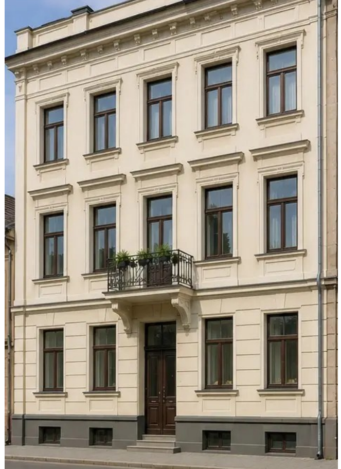
Foto št.14 Fasada stavbe po obnovitvenih delih
