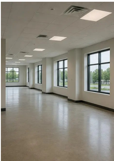
Foto št.13. Notranja zaključna dela v teku
