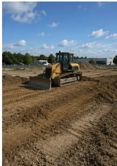
Foto št.2. Pripravljalne dejavnosti na gradbišču v teku
