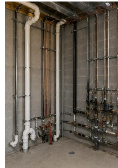
Foto št.12. Montaža vodovodnih sistemov zaključena
