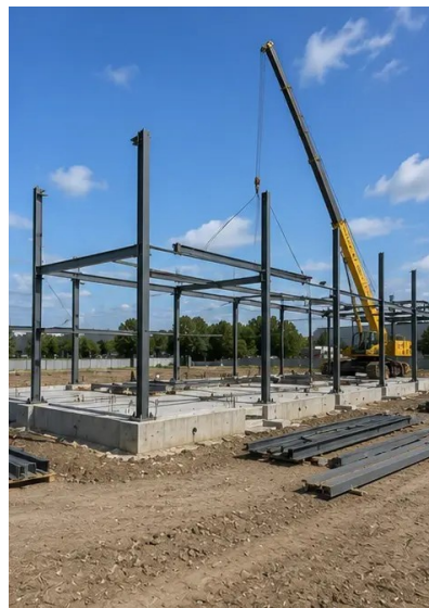
Foto št.6. Montaža nosilne konstrukcije začeta
