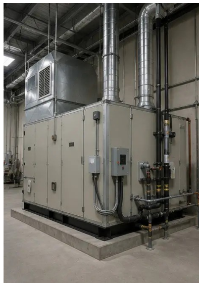
Foto št.14. Montaža opreme zaključena
