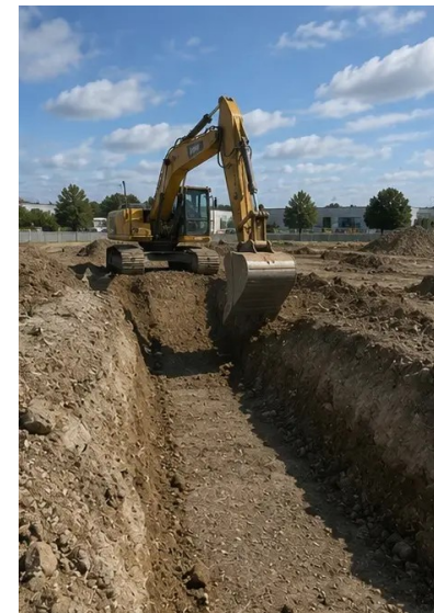
Foto št.4. Začetna izkopna dela zaključena
