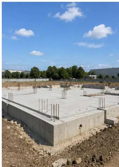
Foto št.5. Gradnja temeljev zaključena
