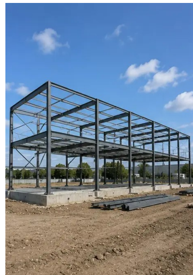
Foto št.7. Gradnja nosilne konstrukcije v teku
