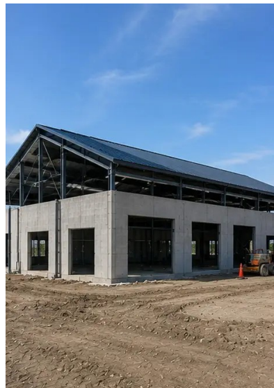
Foto št.10. Gradnja strehe končana
