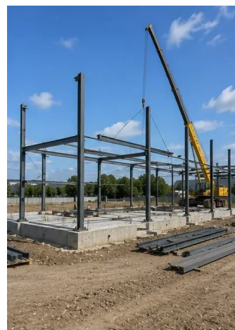
Foto št.6. Montaža nosilne konstrukcije začeta
