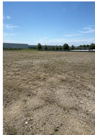
Foto št.1. Gradbišče pred začetkom del
