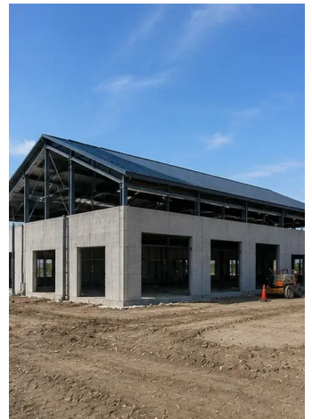
Foto št.10. Gradnja strehe končana
