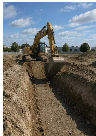
Foto št.4. Začetna izkopna dela zaključena
