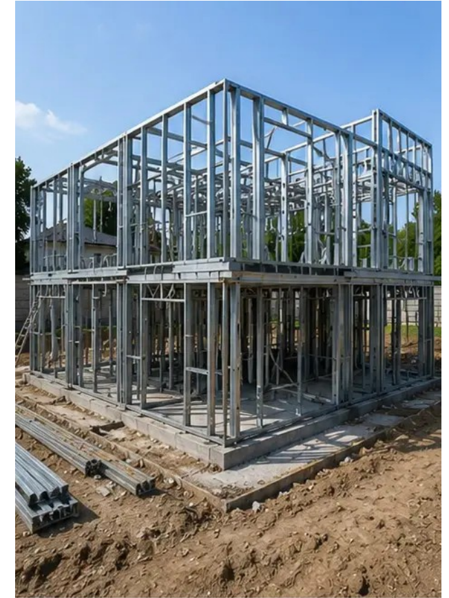
Fotografia č. 6 Montáž nosnej konštrukcie prebieha
