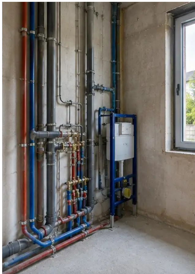
Fotografia č. 10 Inštalácia vodoinštalčných systémov dokončená vo vyhradených oblastiach
