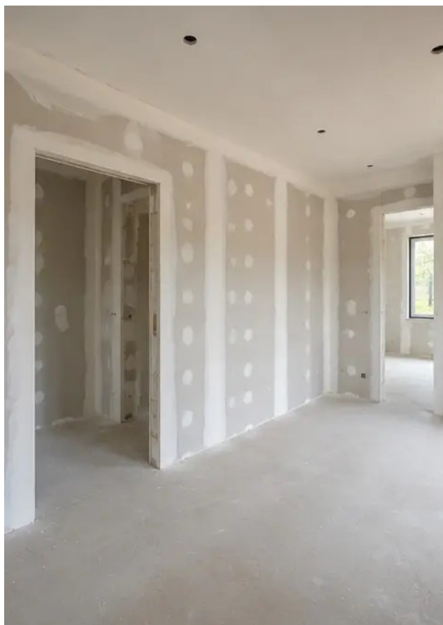
Fotografia č. 11 Dokončovacie práce na vnútorných stenách prebiehajú
