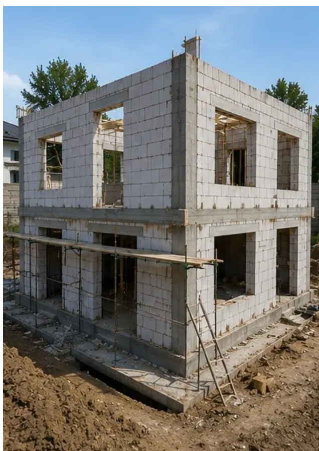
Fotografia č. 7 Výstavba vonkajších stien dokončená pre sekciu budovy
