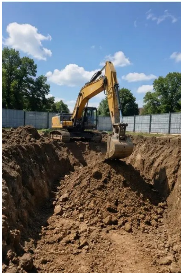
Fotografia č. 2 Výkopové práce vykonané podľa požiadaviek projektu
