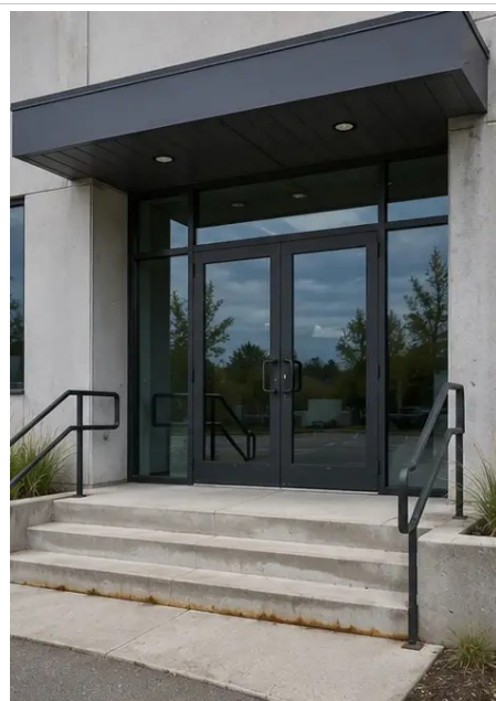
Photo #3. Oblasť hlavného vchodu skontrolovaná a zdokumentovaná
