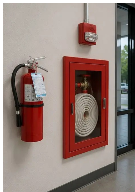
Photo #12. Bezpečnostné zariadenia skontrolované a zaznamenané
