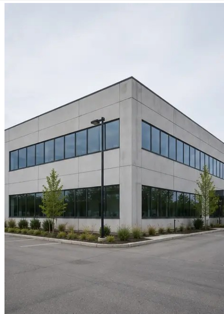
Photo #1. Celkový pohľad na kontrolovanú nehnuteľnosť
