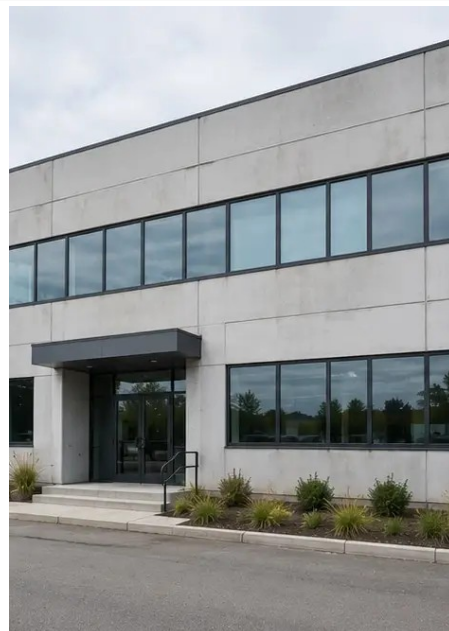
Photo #2. Stav prednej fasády počas prehliadky
