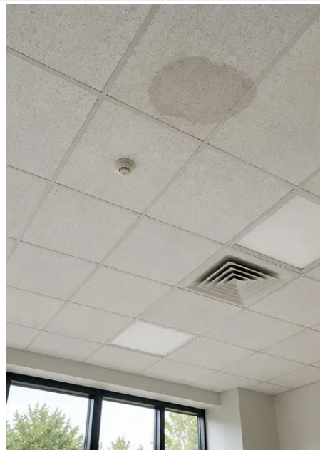
Photo #13. Stav stropu zdokumentovaný počas prehliadky
