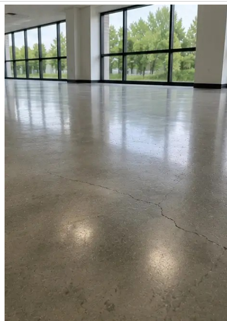
Photo #14. Stav podlahy posúdený a zaznamenaný
