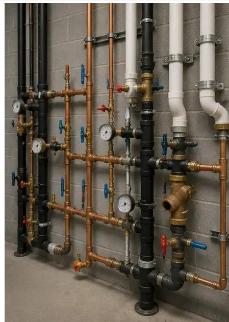
Photo #10. Kontrola vodoinštaláčného systému dokončená
