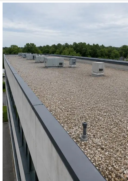
Photo #5. Prehliadka stavu strechy dokončená
