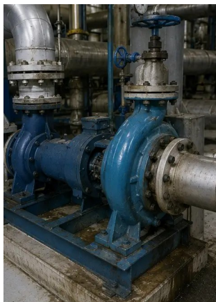
Fotografia č. 3. Stav priemyselného čerpadla posúdený počas údržby
