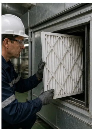
Fotografia č. 7. Výmena vzduchového filtra dokončená
