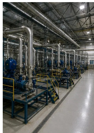
Fotografia č. 16. Celkový prehľad zariadenia po dokončení údržbových prác
