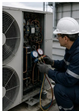
Fotografia č. 6. Stav zariadenia HVAC zdokumentovaný
