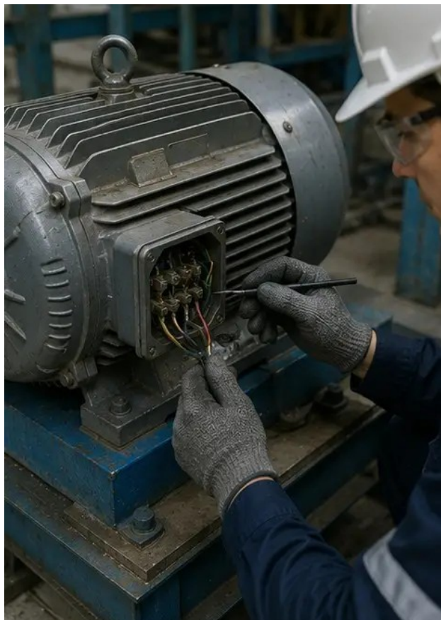
Fotografia č. 4. Kontrola elektromotora dokončená
