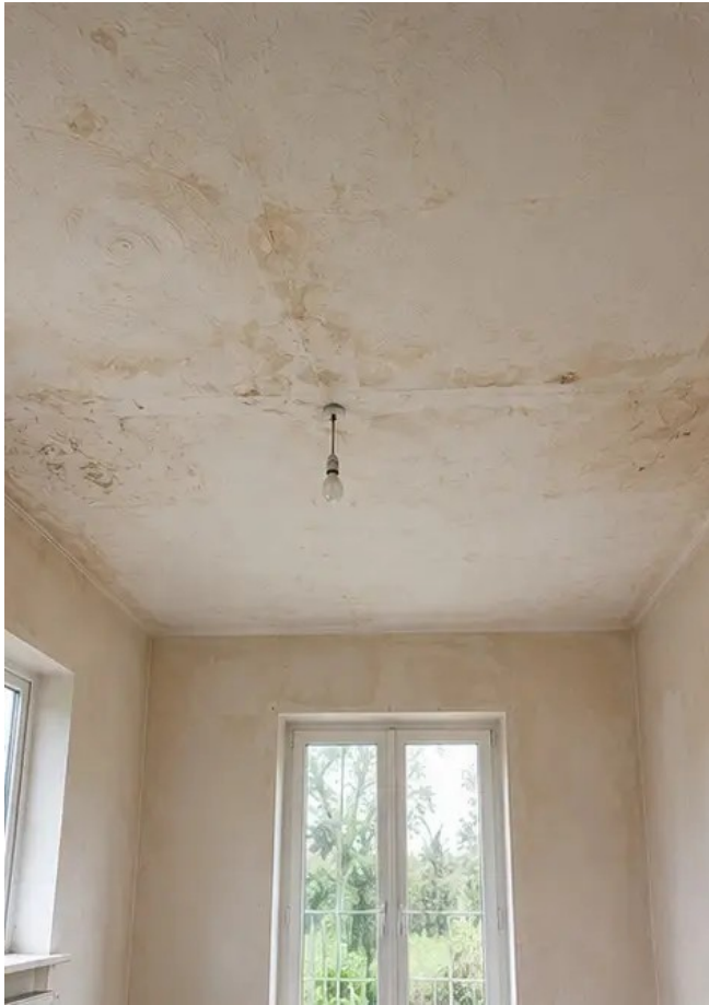
Fotografia č. 7 Stav stropu pred rekonštrukciou
