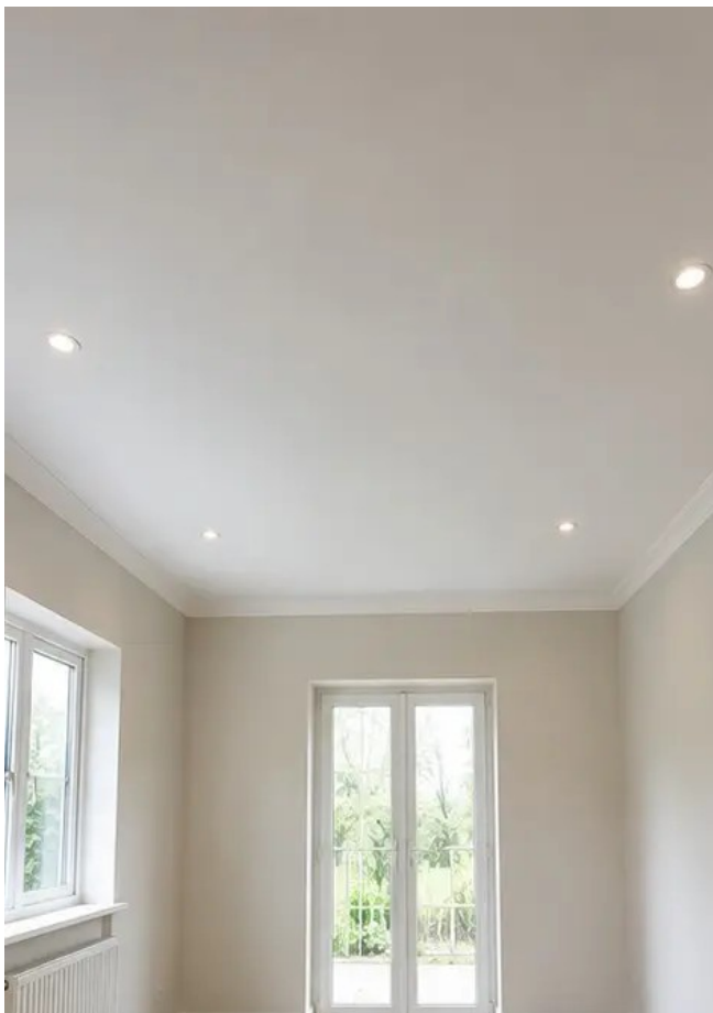
Fotografia č. 8 Stav stropu po rekonštrukcii
