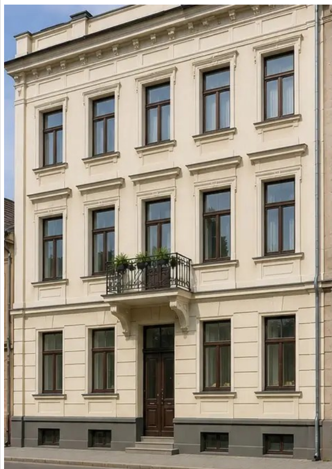
Fotografia č. 14 Fasáda budovy po reštaurátorských prácach
