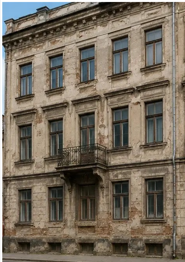
Fotografia č. 13 Fasáda budovy pred reštaurátorskými prácami
