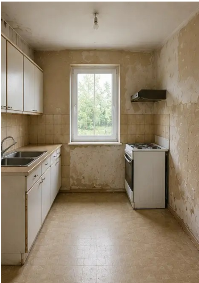
Fotografia č. 11 Stav kuchyne pred rekonštrukciou
