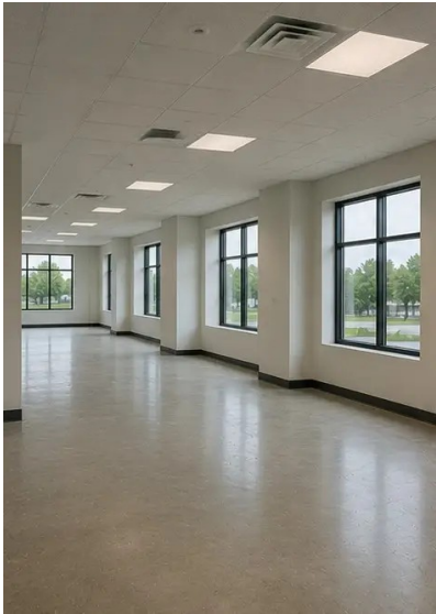
Fotografia č. 13. Vnútročné dokončovacie práce prebiehajú
