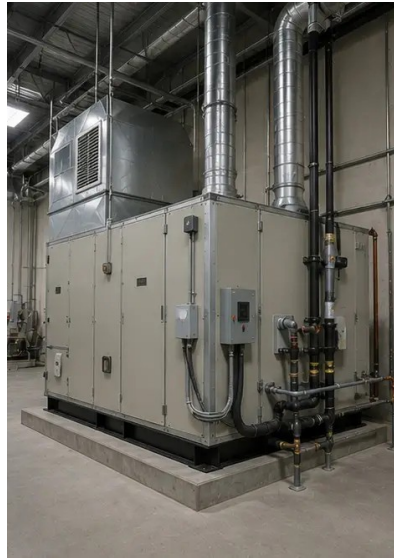
Fotografia č. 14. Inštalácia zariadení dokončená
