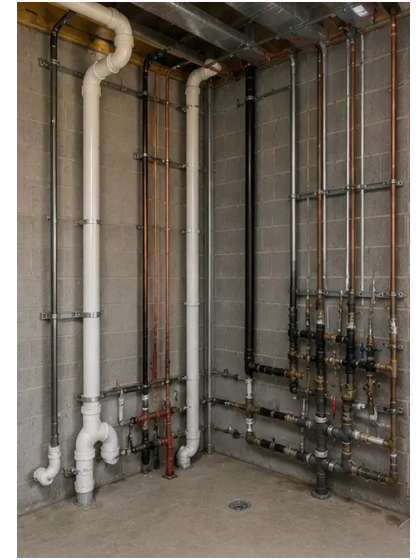
Fotografia č. 12. Inštalácia vodoinštaláčnych systémov dokončená
