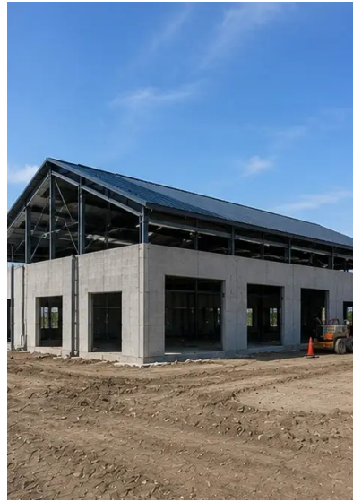
Fotografia č. 10. Konštrukcia strechy dokončená
