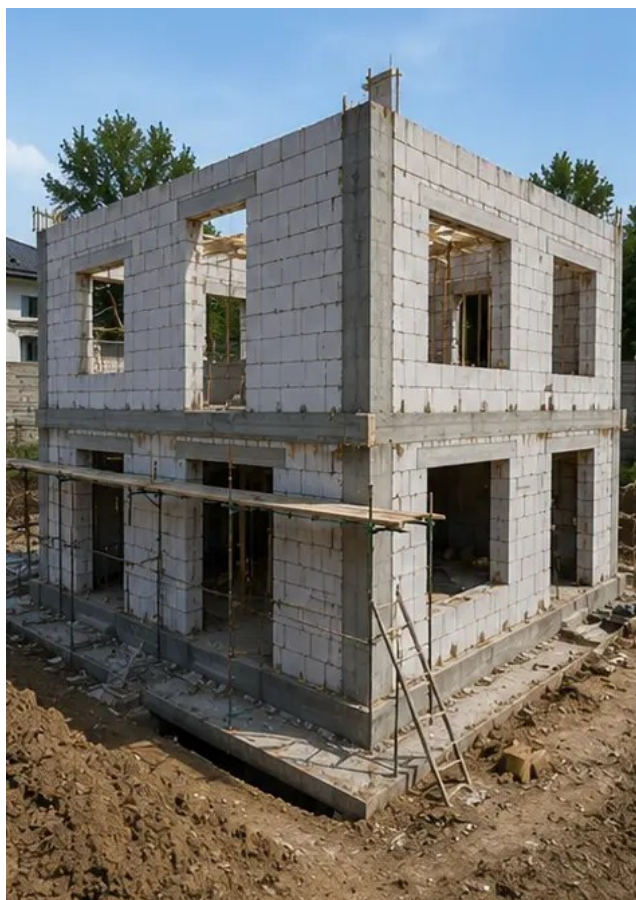
Фото №7 Возведение наружных стен завершено для секции здания
