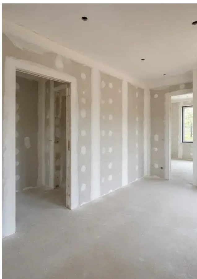
Фото №11 Отделочные работы внутренних стен в процессе
