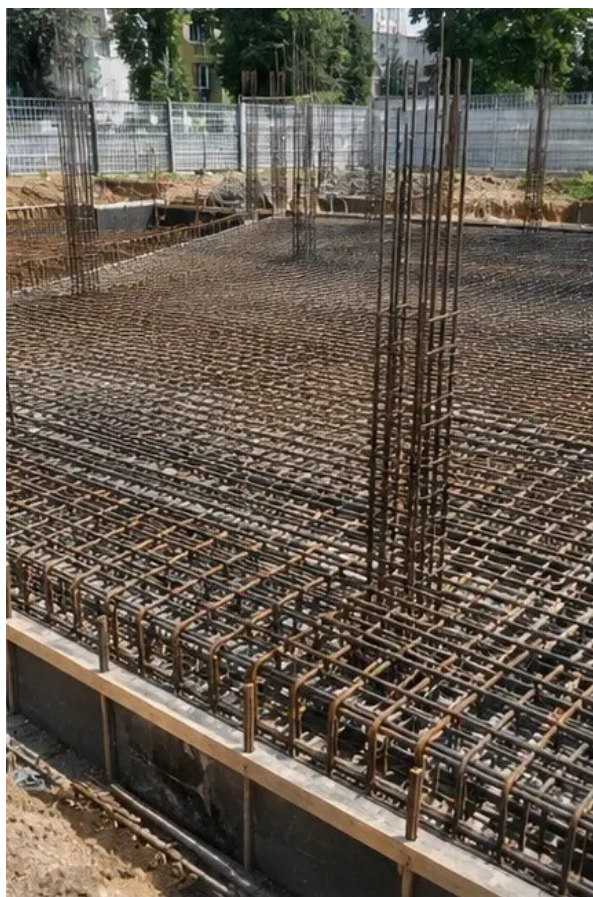
Фото №4 Установка арматуры завершена перед бетонированием
