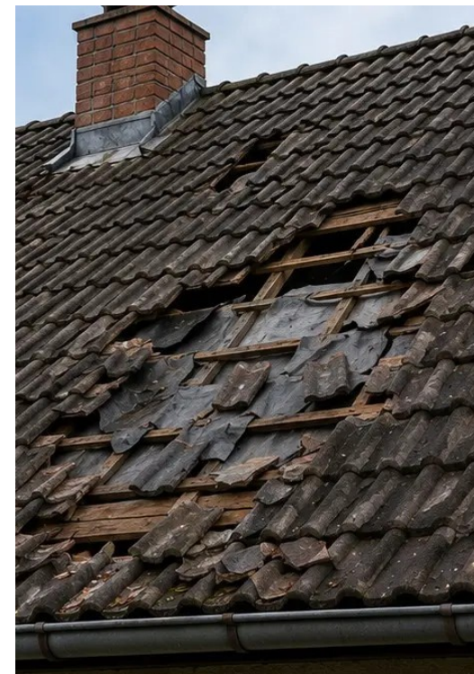
Фото №3 Поврежденный участок крыши идентифицирован и зафиксирован
