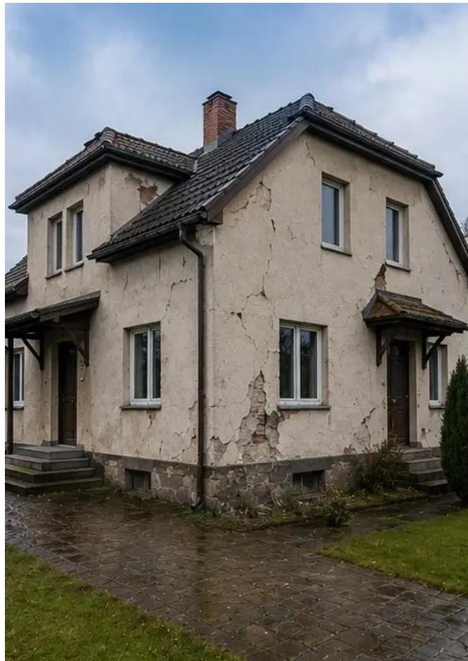
Фото №1 Общий вид осмотренного объекта недвижимости
