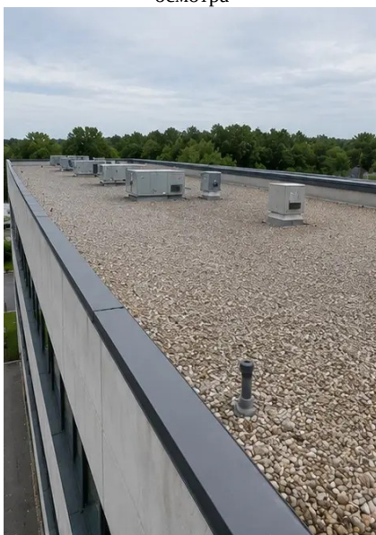
Photo #5. Осмотр состояния крыши завершен
