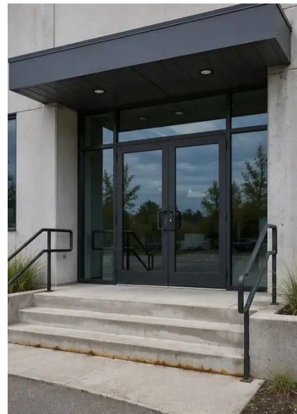
Photo #3. Зона главного входа осмотрена и задокументирована
