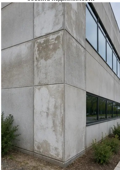
Photo #4. Состояние наружных стен зафиксировано во время осмотра
