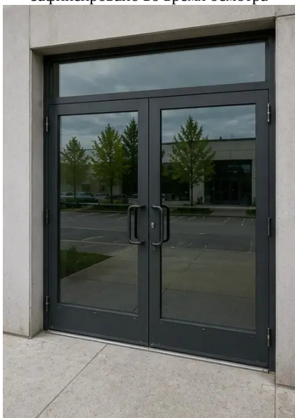
Photo #7. Состояние дверей осмотрено и зафиксировано
