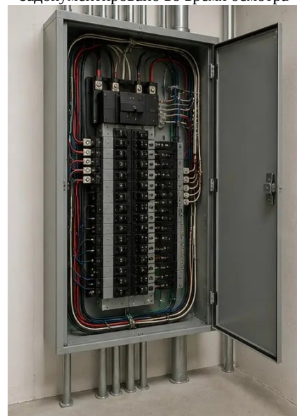
Photo #9. Состояние электрощита задокументировано
