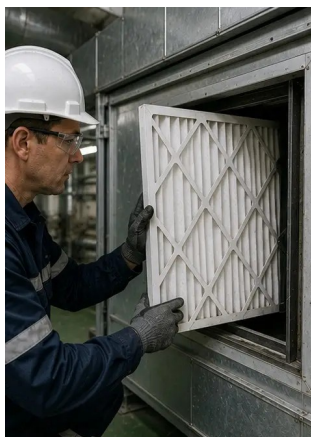
Фото №7. Замена воздушного фильтра завершена
