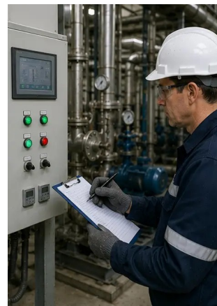
Фото №14. Итоговая проверка технического обслуживания выполнена
