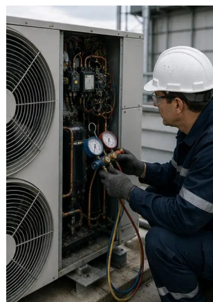
Фото №6. Состояние оборудования ОВКВ задокументировано
