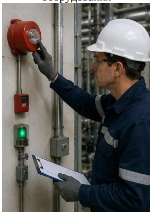
Фото №13. Осмотр системы безопасности завершён
