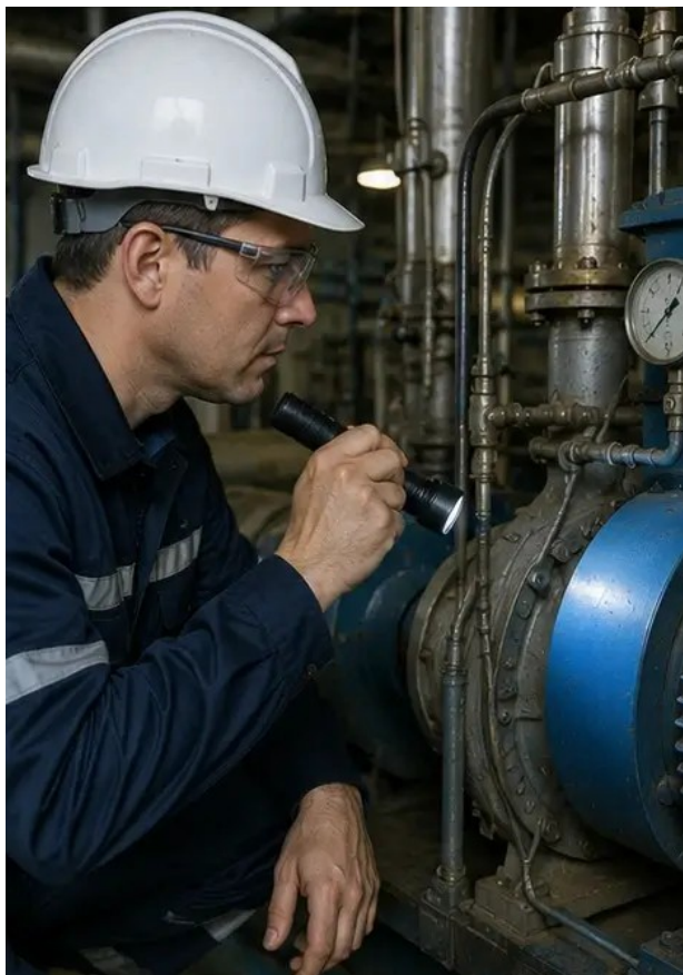
Фото №2. Осмотр механического оборудования завершен
