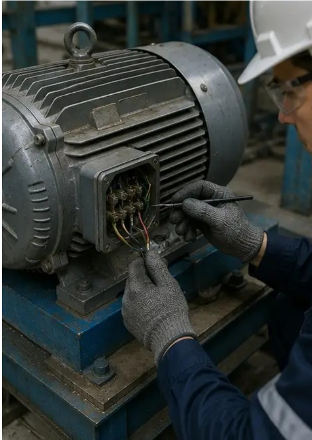
Фото №4. Осмотр электродвигателя завершен
