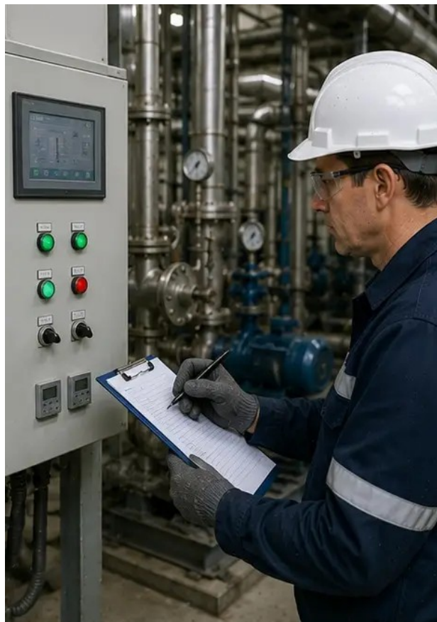
Фото №14. Итоговая проверка технического обслуживания выполнена
