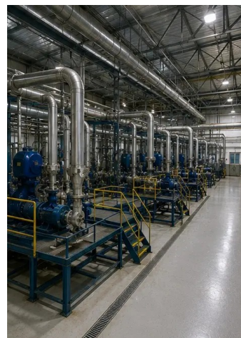
Фото №16. Общий обзор объекта после завершения работ по техническому обслуживанию
