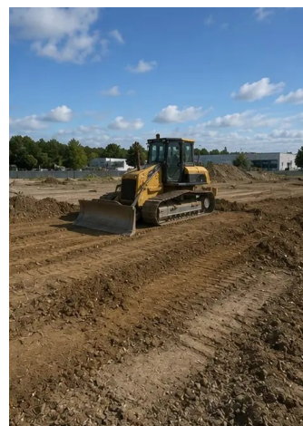
Фото №2. Подготовительные мероприятия на площадке в процессе
