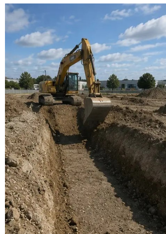
Фото №4. Первоначальные земляные работы завершены
