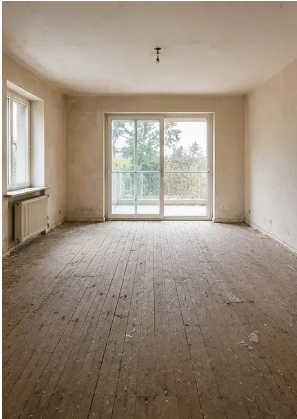
Фото №1 Состояние гостиной до ремонта
