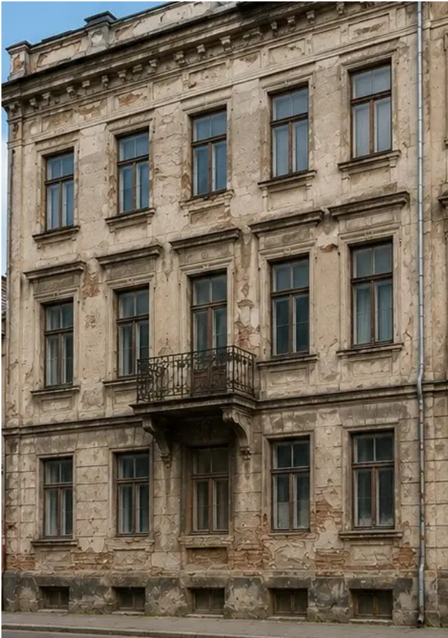
Фото №13 Фасад здания до реставрационных работ
