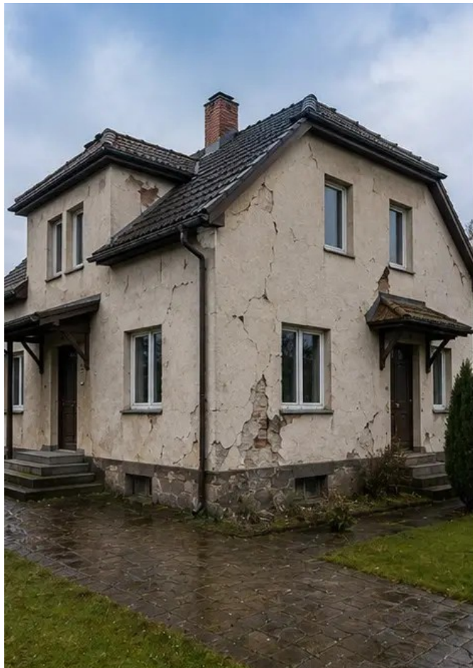
Foto nr.1 Vedere generală a proprietății inspectate
