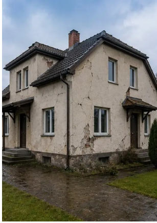
Photo #1. Vedere generală a proprietății inspectate
