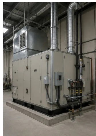
Foto nr.14. Instalarea echipamentelor finalizată
