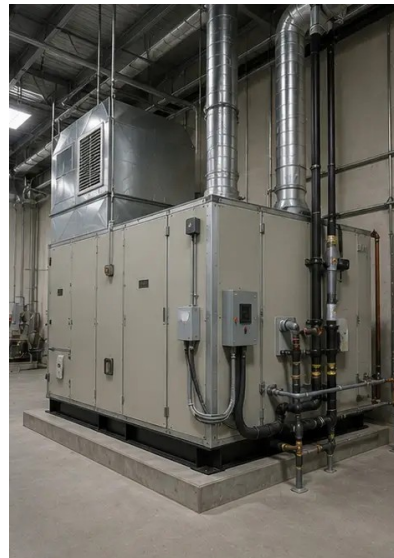
Foto nr.14. Instalarea echipamentelor finalizată
