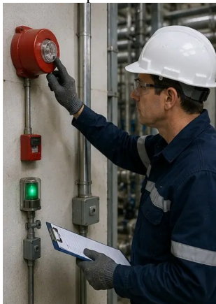
Foto nr.13. Inspecția sistemului de siguranță finalizată
