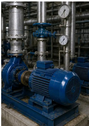
Foto nr.15. Echipamentul funcționează normal după mentenanță
