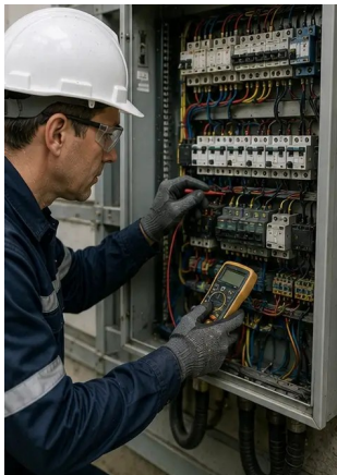
Foto nr.5. Inspecția dulapului electric efectuată
