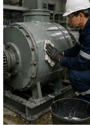
Foto nr.12. Procedura de curățare a echipamentului finalizată
