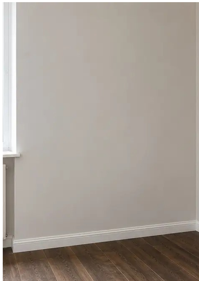
Foto nr.4 Starea peretelui după lucrările de reparație
