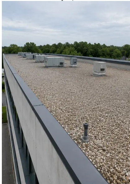
Photo #5. Inspecția stării acoperișului finalizată
